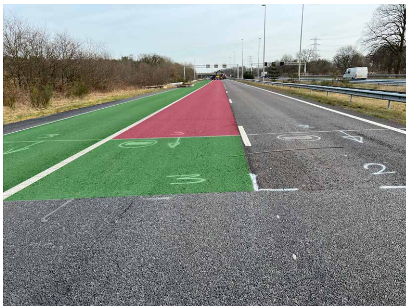
Figuur 5: In de praktijk; de wegvakken zijn aangeduid met steenslagklassen en worden apart gefreesd
